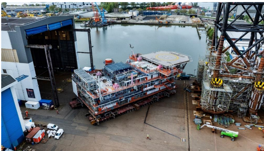
Productieplatform N05-A in aanbouw
