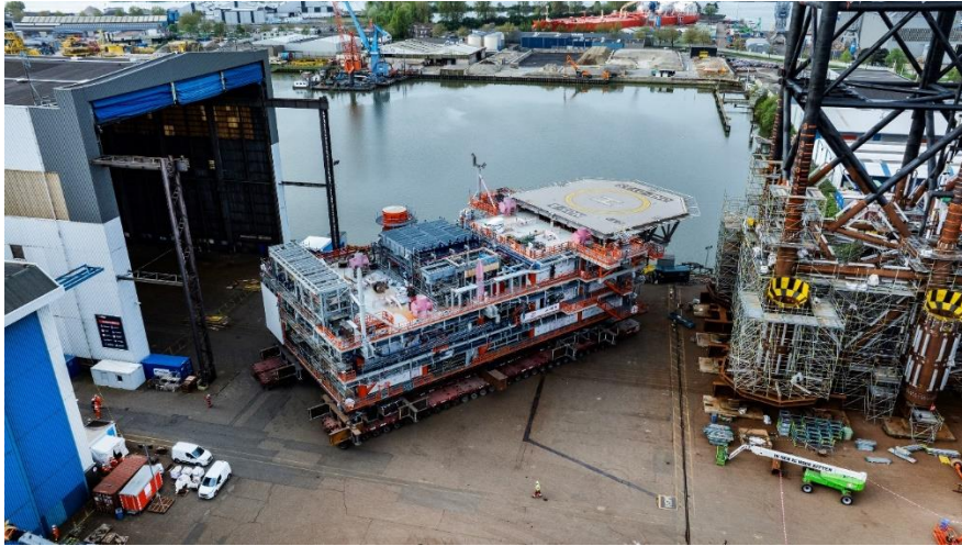
Produktionsplattform N05-A im Bau
