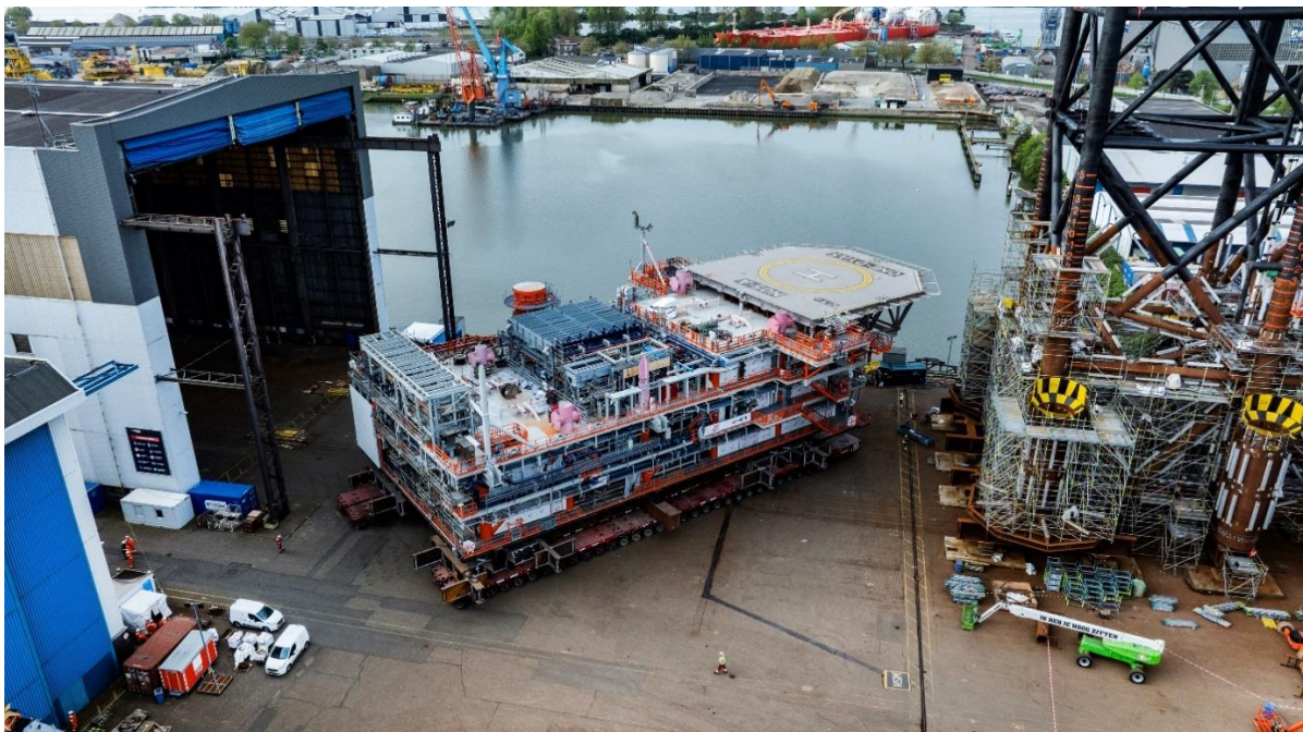
Produktionsplattform N05-A im Bau
