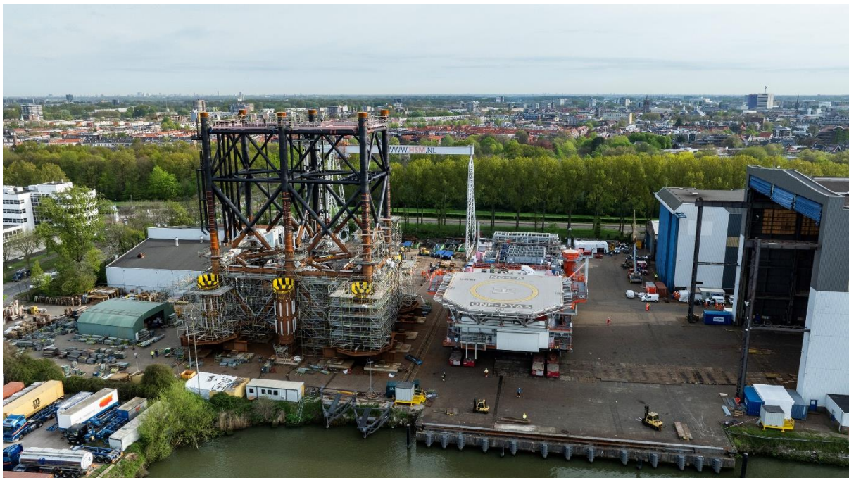
Productieplatform N05-A in aanbouw
